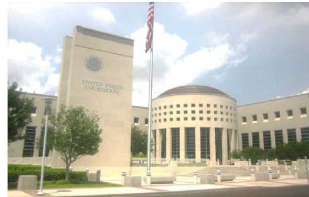
Zgrada okružnog i stečajnog suda u gradu Laredo u Teksasu
